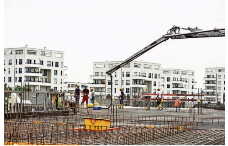
Anspruchsvolle Betonarbeiten auf dem Rewag-Areal
